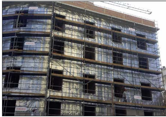
Fig. 1: Colocación de aislamiento de aluminio reflectivo
