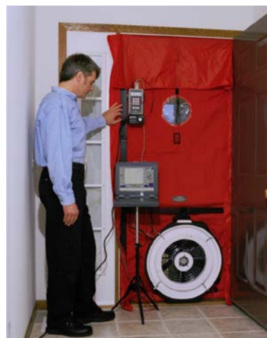
Fig. 8: Proceso de control durante la realización del ensayo "Blower Door" en la puerta de entrada de una vivienda.
