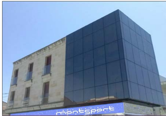
Fig.1: Fachada aplacada combinada con un muro cortina
