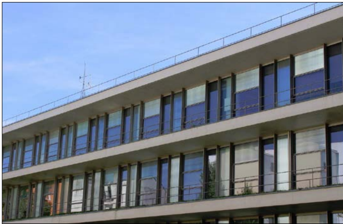
Fig.11: Fachada-panel con subestructura de aluminio anodizado y lunas de vidrio con áreas tintadas y no tintadas. Sobresale un voladizo con inclusión de vegetación sobre él
